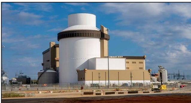
5. ábra: Az épülő Vogtle 3 AP1000 blokk 2022 októberében [8]
