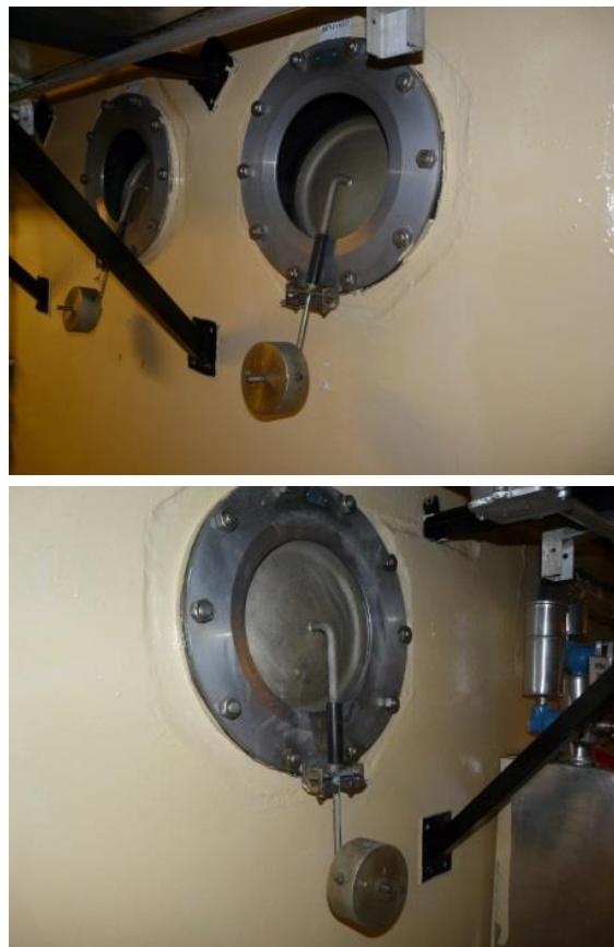
3. ábra: Egyirányú levegőáramlást biztosító „KID” csappantyúk (forrás: az ábra Káldi Tamás munkája)
