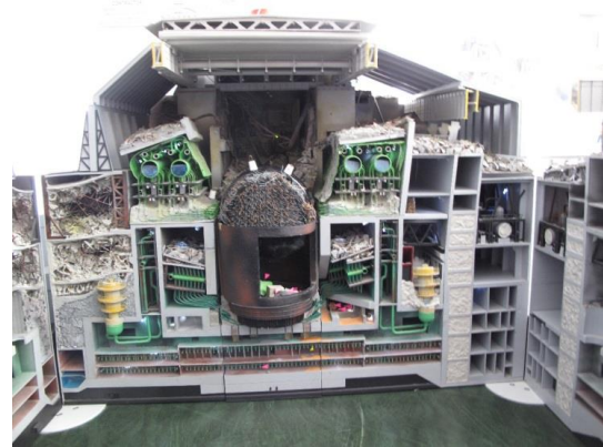
4. ábra: 4. blokki reaktorépület modell. A sérült építmény a védmű elkészülte utáni állapotban. Látogató Épület, Csernobil Atomerőmű (fotó: Móga István).
