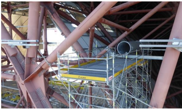
8. ábra: Szerelőállvány a 12 m keresztmetszeti magasságú, acél rácsos ívtartó rúdjai között ([2]).
