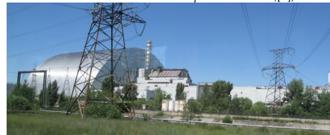
12. ábra: A fedőszerkezet DK-i látképe, a végleges helyén. Előtérben a 3. blokk épülete a közös szellőzőkéménnyel (fotó: Móga István).
