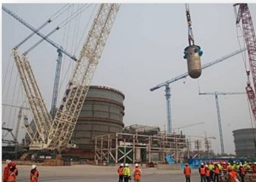
2. ábra: Az első AP1000 reaktortartály beemelések, Sanmen és Haiyang (forrás: Flickr)
