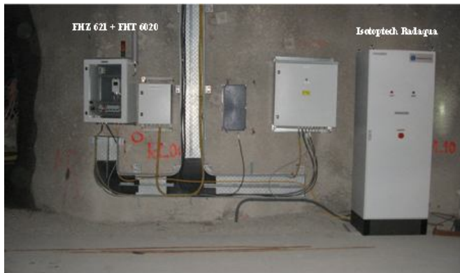
2. ábra: I-K1 tárolókamra előtti SER berendezések
